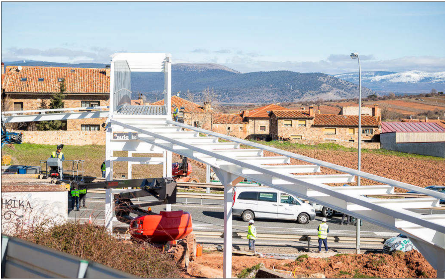
Trabajos de instalación de la estructura superior de la pasarela entre Soria y Las Casas. MONTESEGURO FOTOS
